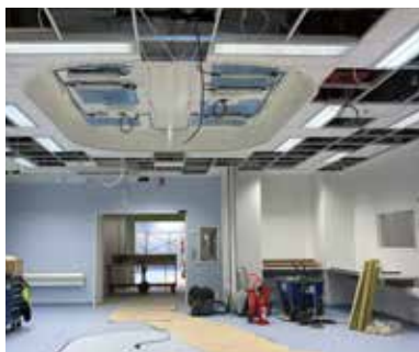
Monteringsarbetet pågick under närmare 9 månader.
