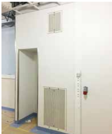
CRCs luddavskiljare är robusta, lättstädade och finns i samtliga operationssalar och många biutrymmen.
